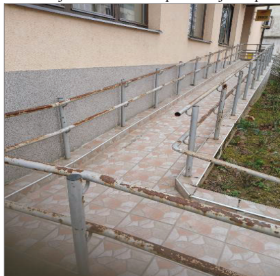
Slika broj 1. Prilazna rampa za objekat pošte
